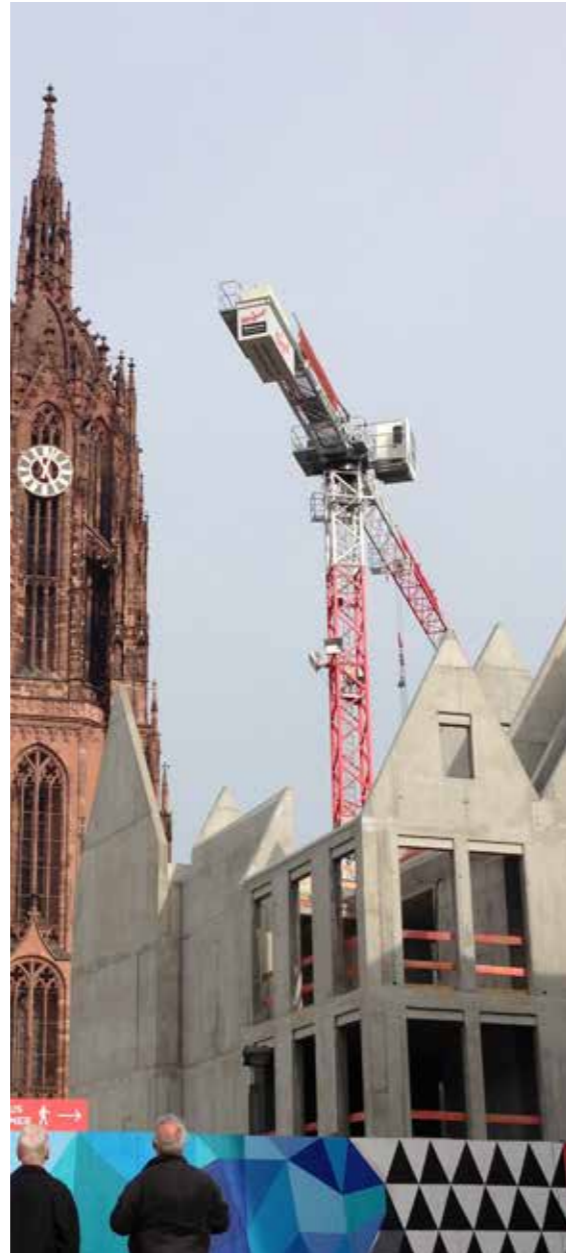
Start der 35 neuen Gebäude welche bis 2016 gebaut werden
